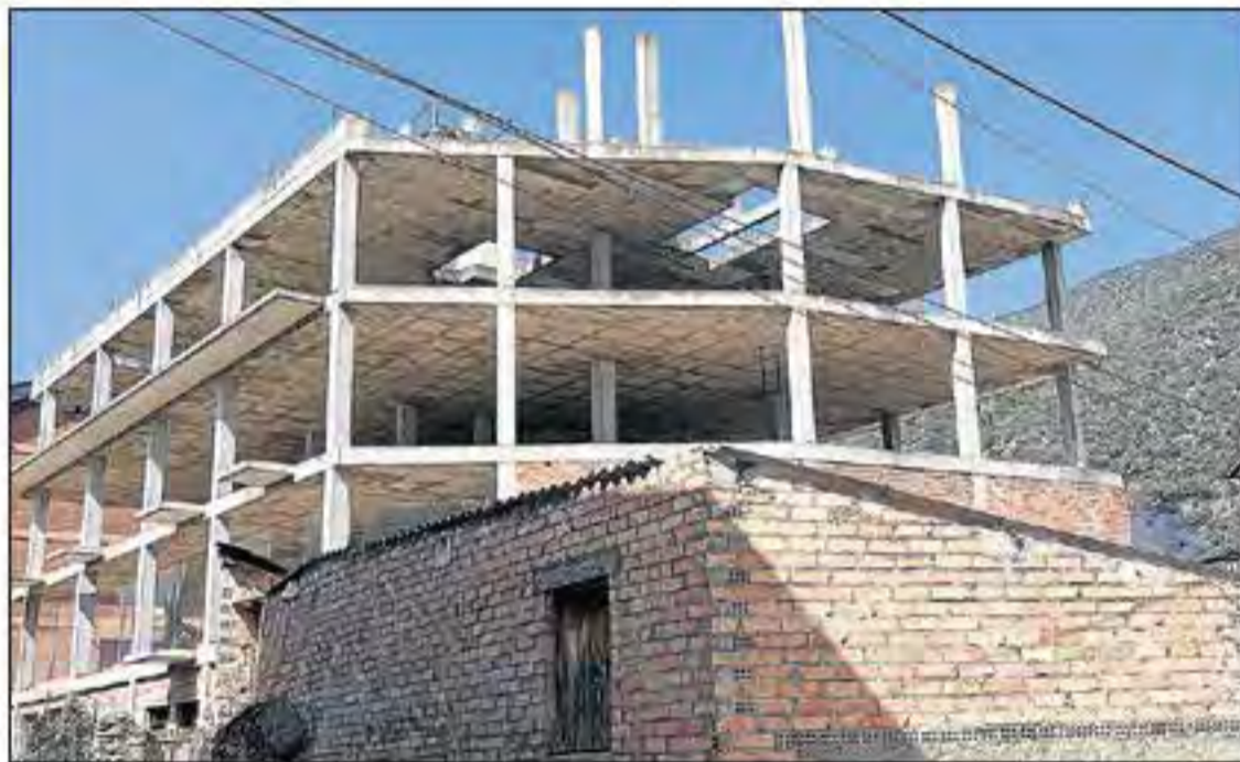
L'edifici a mig construir al carrer la Solana de Sort.
