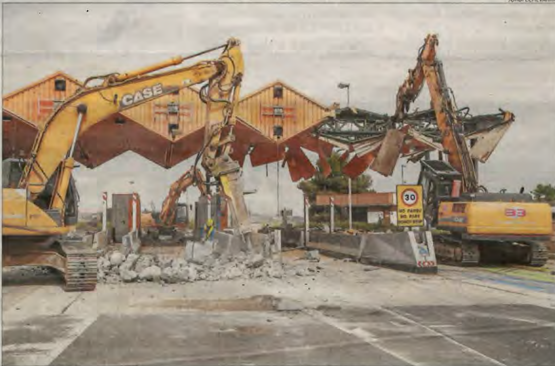
Demolició de la cabina del peatge de Soses a l'AP-2, el març del 2022.
