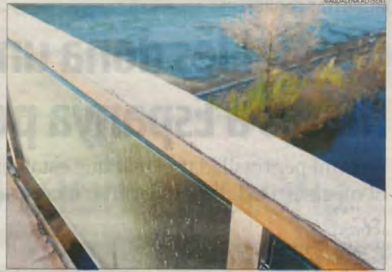
La ciutat de Lleida es va despertar ahir amb temperatures sota zero.
