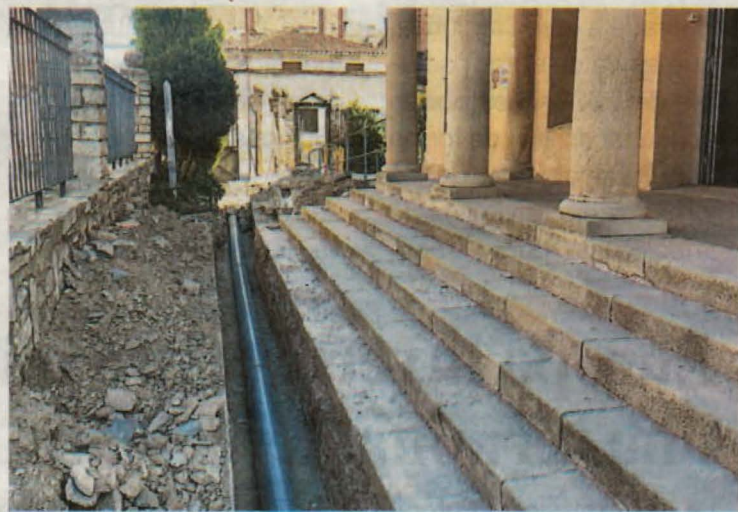
FOTO_Aj. Tàrrega Obres que s'estan fent al centre
