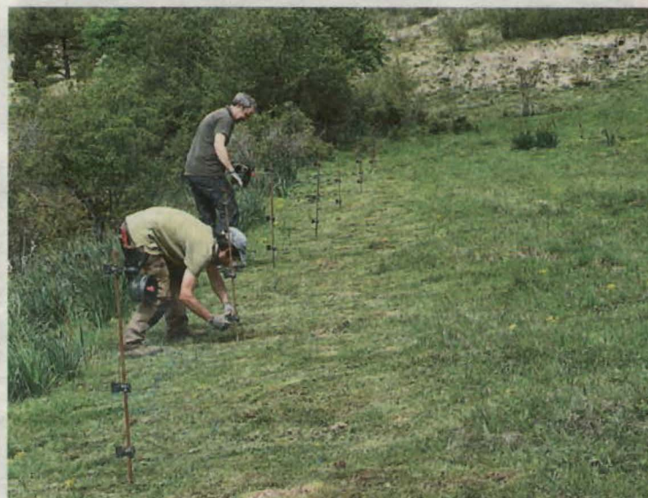
FOTO_ACN Tècnics construint una tanca electrificat
