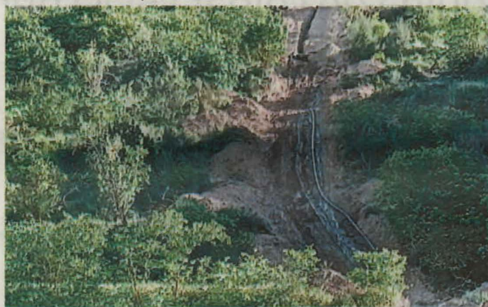
FOTO_Aj. Camarasa Imatge de les obres actuals
