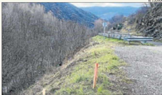
Primers treballs de topografia per a la via verda.
