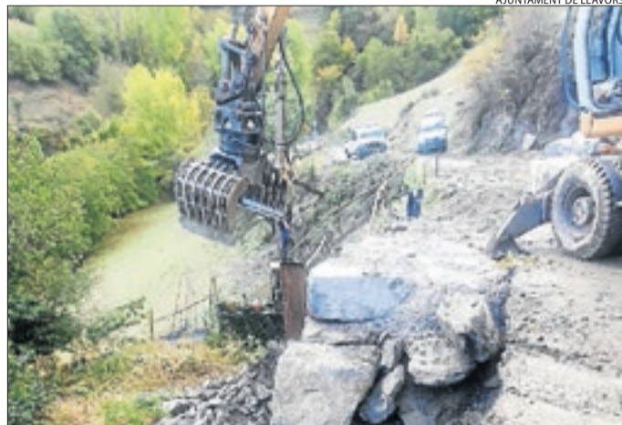
Les obres han finalitzat aquesta setmana.
