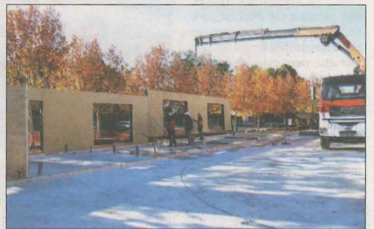
FOTO: ACN / Muntatge del nou edifici que acollirà el hub de la fusta
