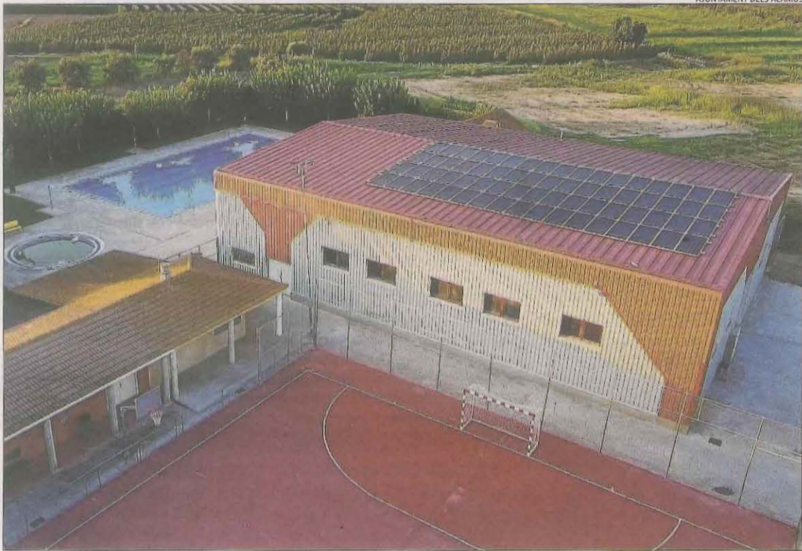
Imatge d'arxiu de panells solars al poliesportiu dels Alamús.
