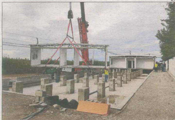
Els treballs per instal·lar el mòdul a l'escola de Tàrrega.
