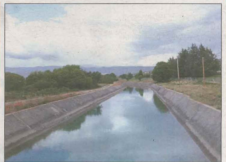
FOTO: Endesa / Imatge del canal hidroelèctric de Gavet, al Jussà
