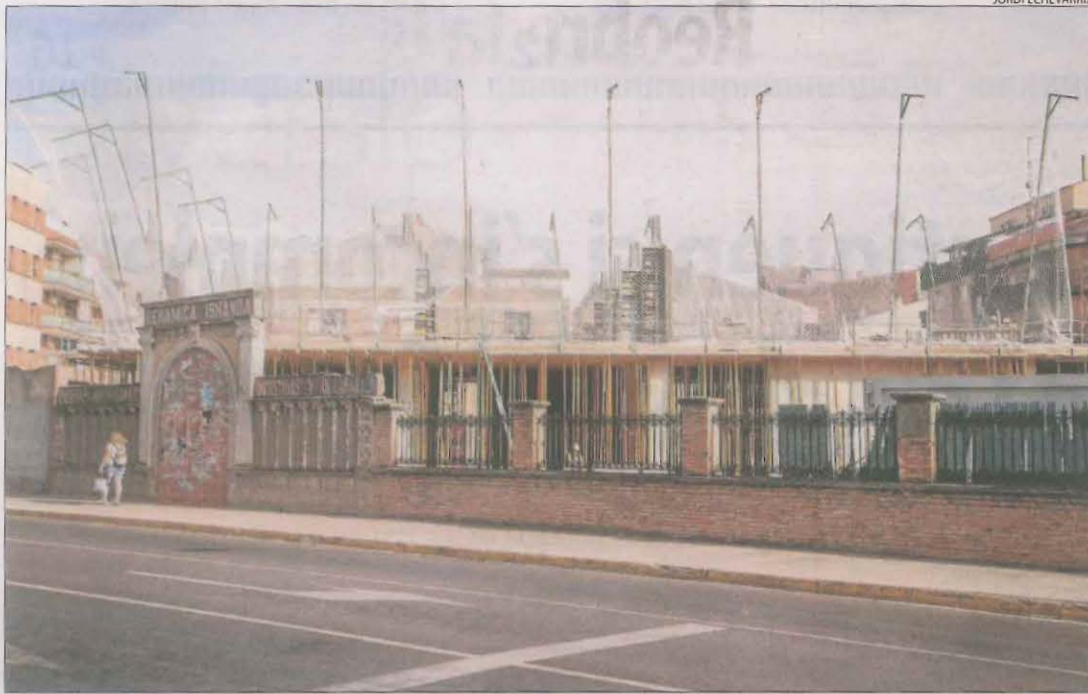
Imatge de les obres de la nova residència de Mollerussa.
