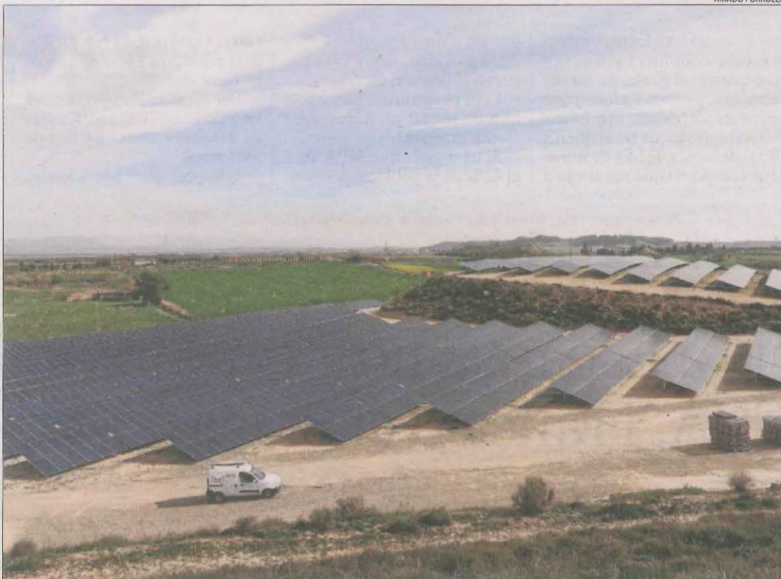
Imatge d'arxiu de panells solars instal·lats a Almacelles.
