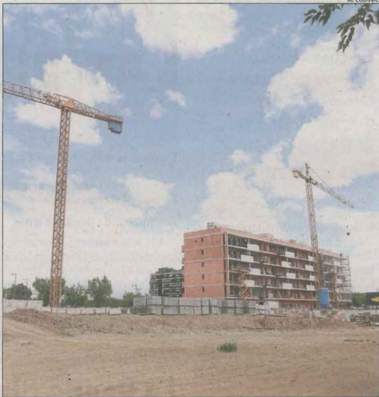
Imatge d'arxiu d'habitatges en obres a Lleida ciutat.
