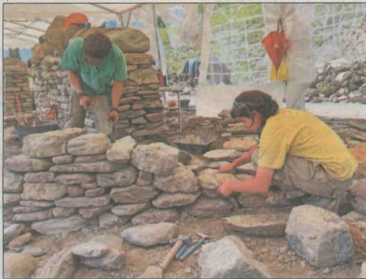
FOTO: ACN / Dos alumnes aixecant una paret de pedra seca
