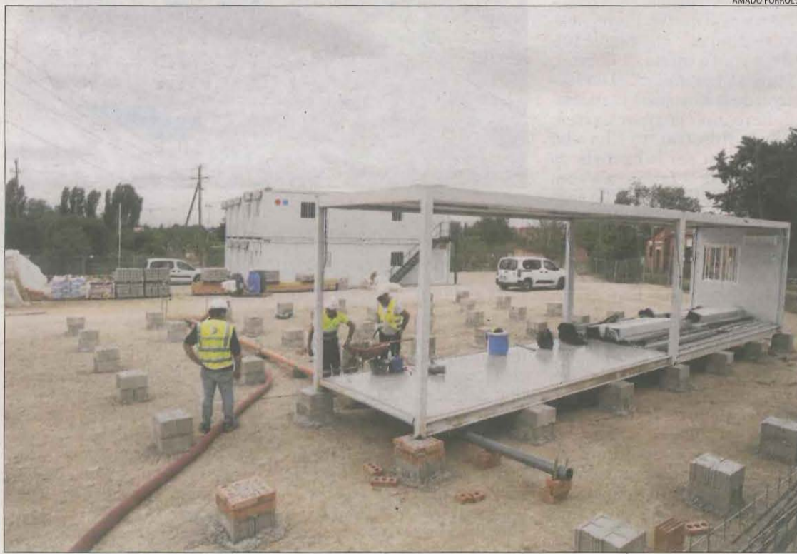
Aquests mòduls serviran de zona logística als obrers que construiran l'edifici de consultes externes.
