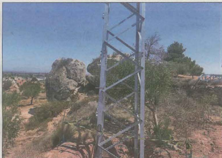
FOTO: Aj. Borges Blanques / La instal·lació que s'ha paralitzat
