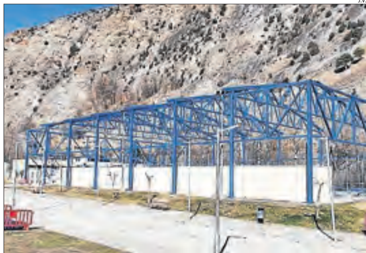
Les obres per cobrir la pista poliesportiva de Llavorsí.
