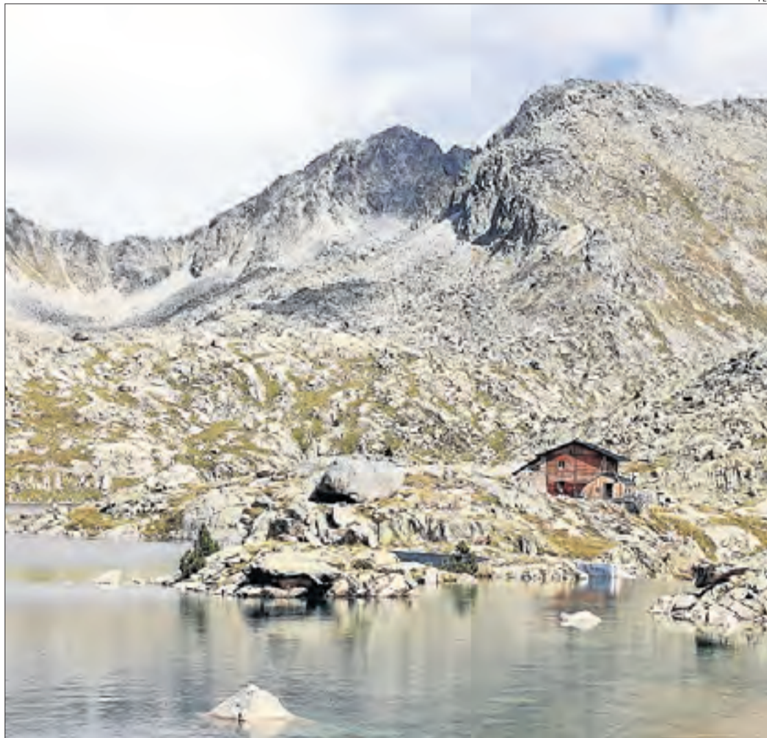
Colomina, coneguda com Casa Keller, és una de les tres construccions cedides per Endesa a la FEEC.
