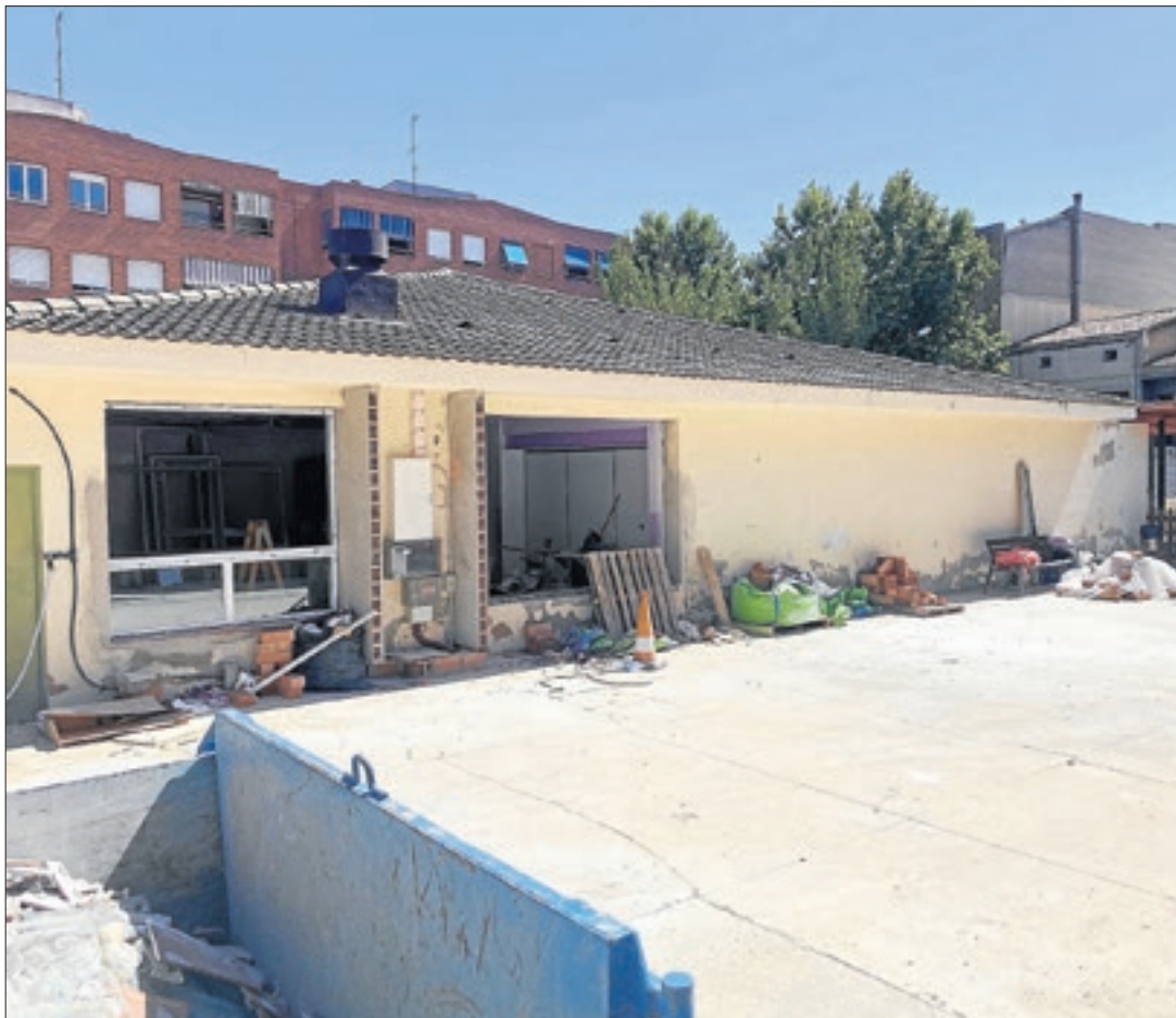
Estat actual de les obres d'adequació de les aules d'Infantil al col·legi Joan Maragall.
