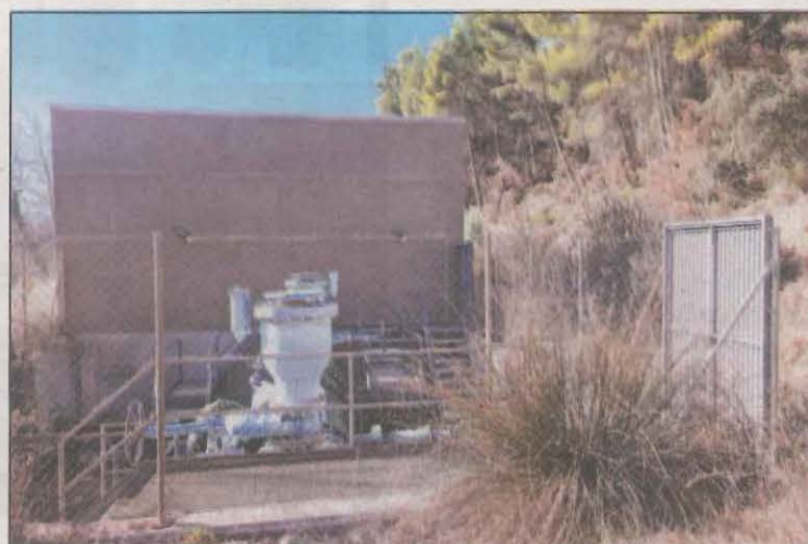
FOTO: M.Lluvich (ACN) / Part de les obres de la primera fase del reg
