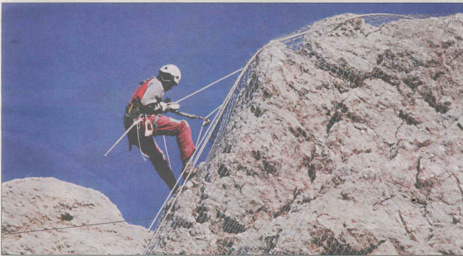
FOTO: Tony Alcántara / Un operario colocando las mallas de seguridad en la Peña de l'Espígol
