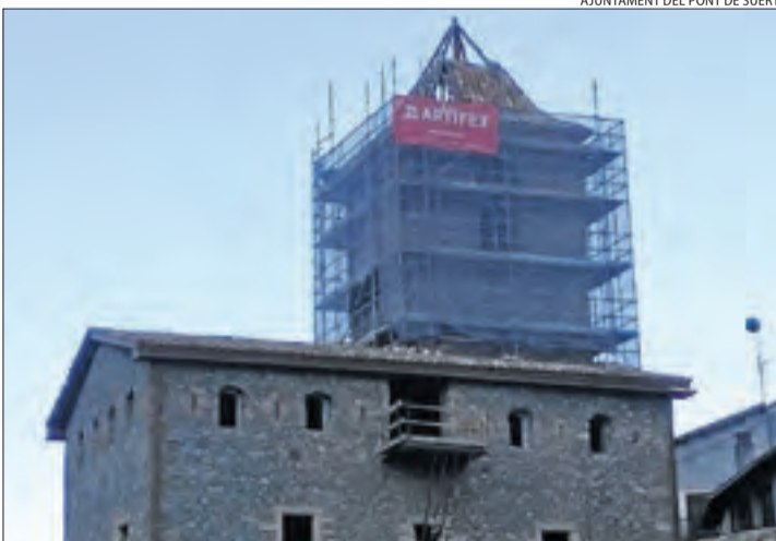
Imatge d'arxiu de les obres al Palau Abacial.
