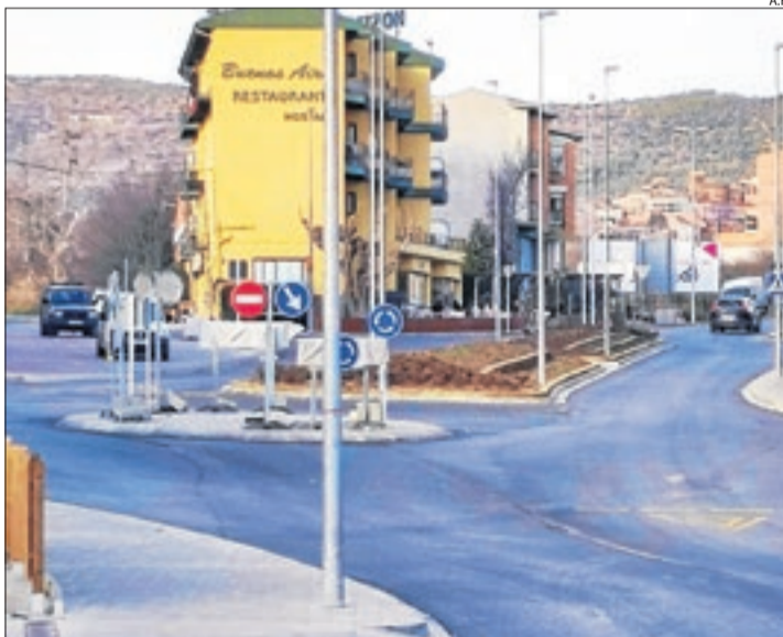
La polèmica rotonda de la C-13 a Tremp ja està finalitzada.
