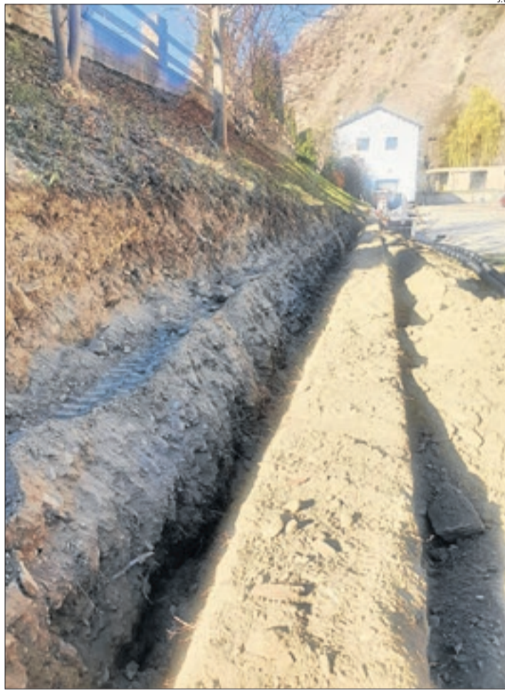
Les rases per on discorreran els tubs de la instal·lació.
