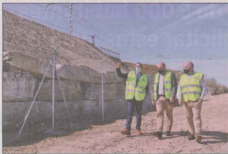
FOTO: ACN / Crespín, a l'esquerra, va visitar ahir les obres
