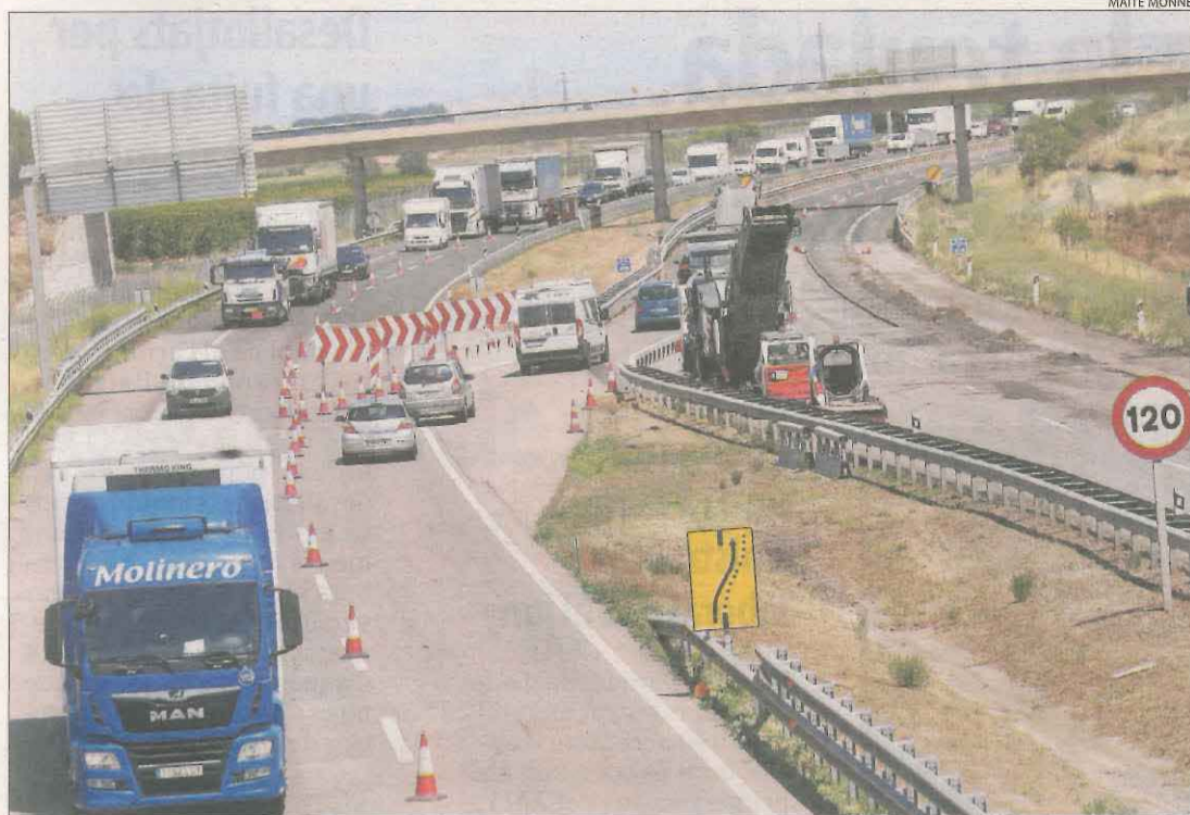
Retencions ahir a l'A-2 per les obres que l'Estat porta a terme per reparar el ferm.
