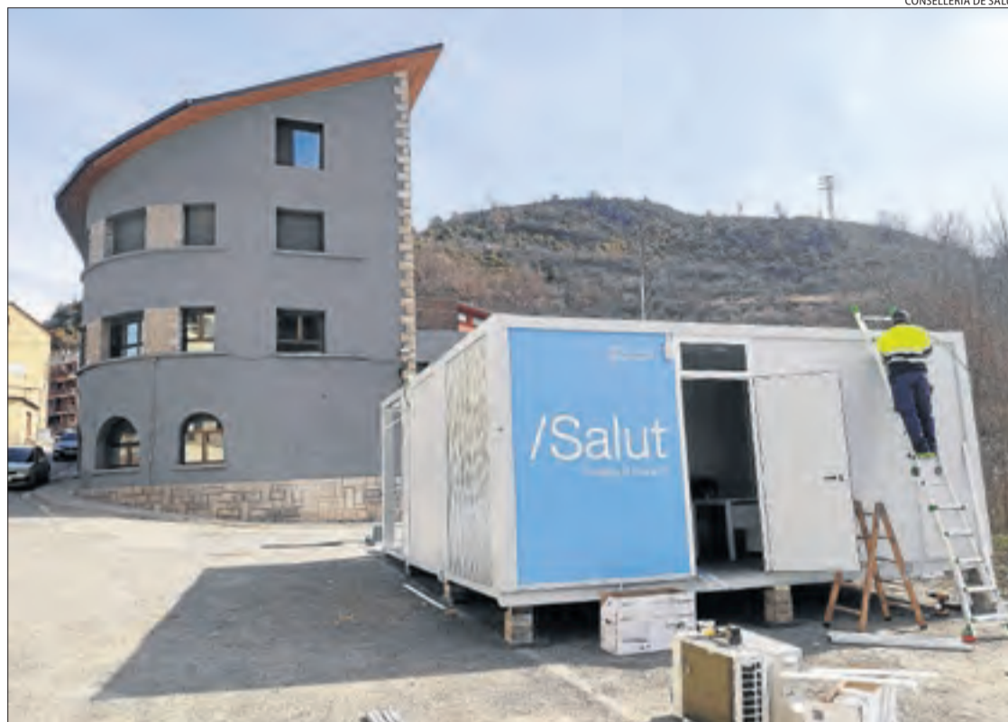
Instal·lació del mòdul prefabricat per al centre d'Atenció Primària del Pont de Suert.
