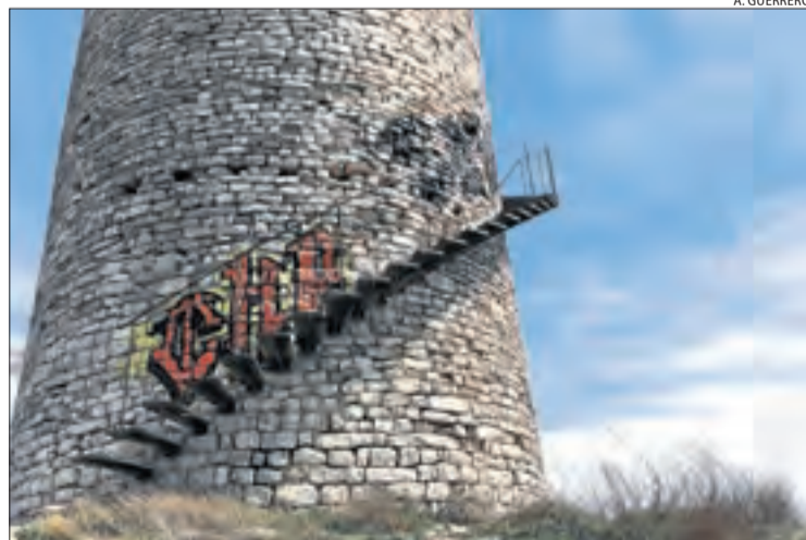
Imatge de les pintades a l'exterior de la torre.
