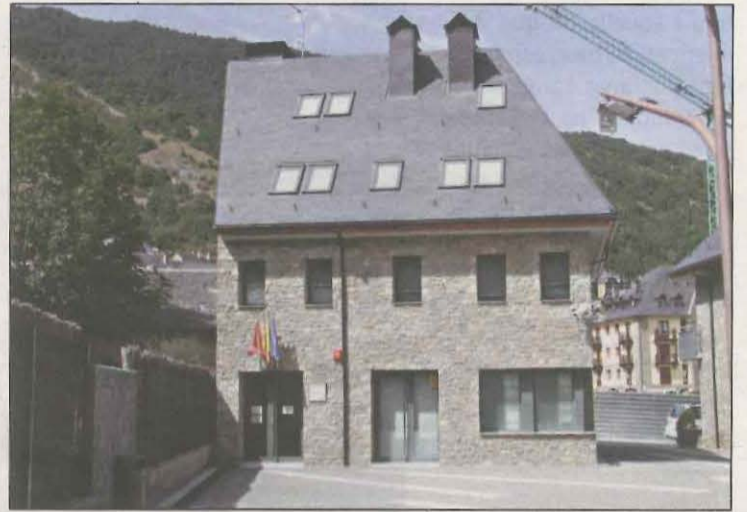
FOTO: Aj. Vielha / Façana dels jutjats de Vielha, on va declarar Berdie
