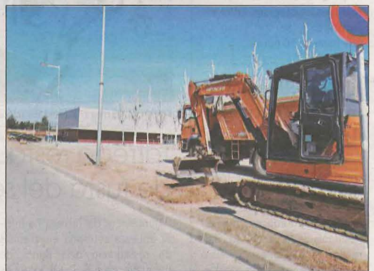
FOTO: Paeria/ El termini d'execució de les obres és de tres mesos
