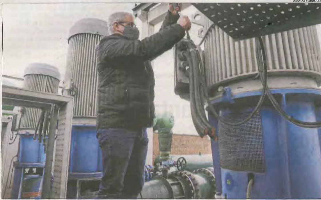
Un operari, al reparar ahir les connexions en una de les bombes afectades a l'estació de Castelló.
