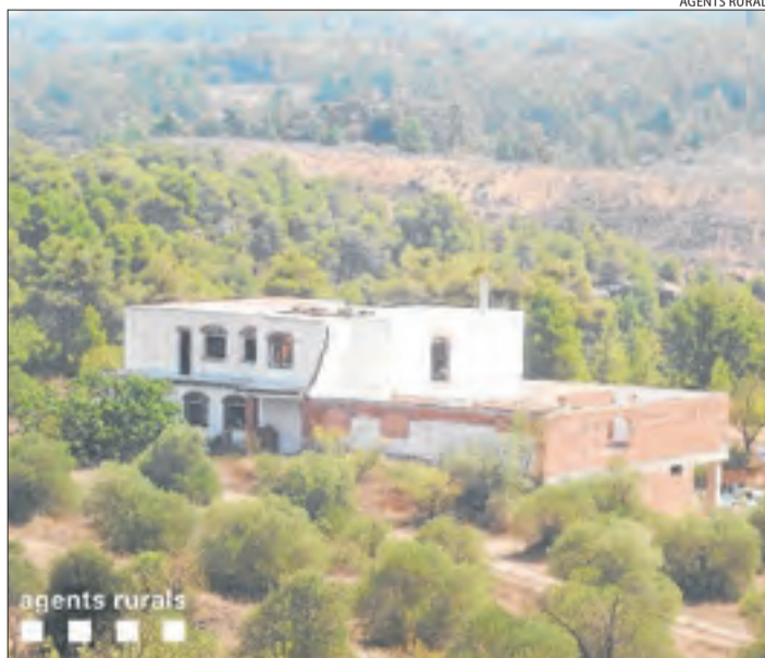
Imatge de l'edifici que s'ha enderrocat.
