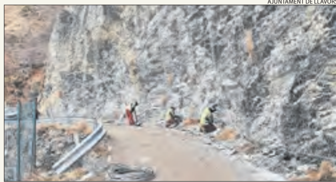
La instal·lació de les malles metàl·liques a Romadriu.
