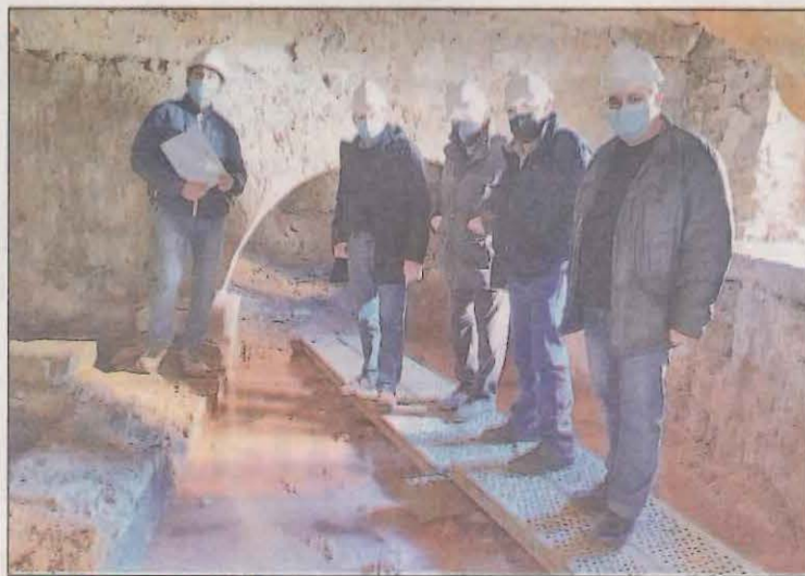
FOTO: C.C. Pallars Jussà / Les obres de les adoberies ja han començat
