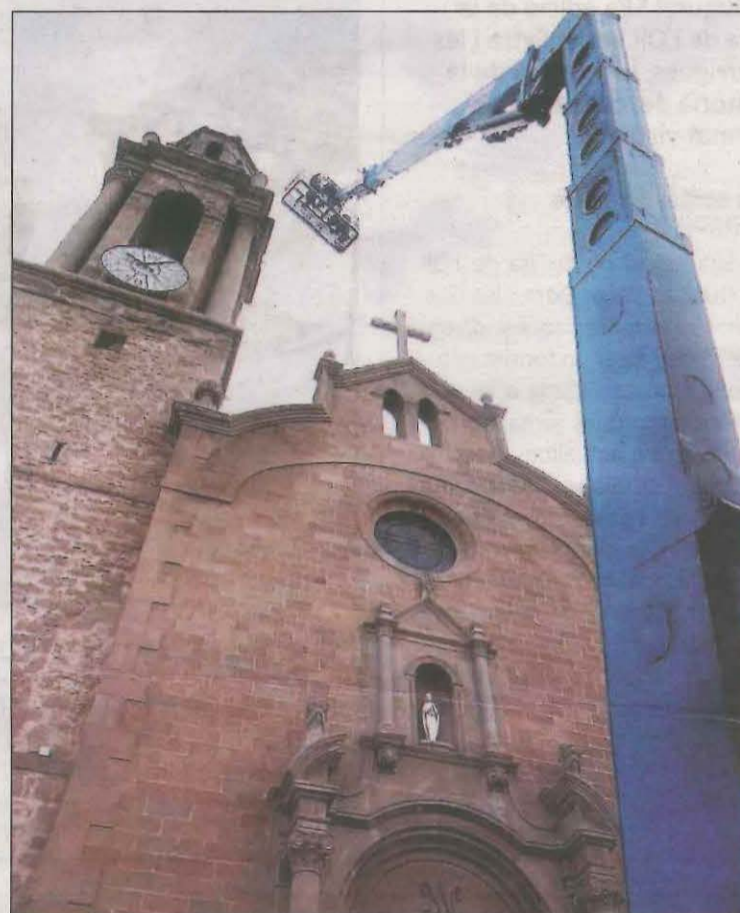
FOTO: Aj. Montgai / Els operaris treballaven a gran altura
