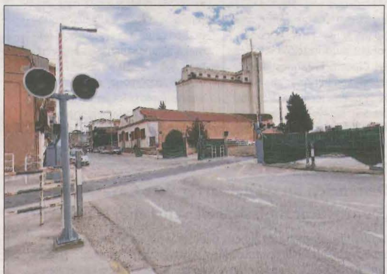
FOTO: FGC / Es substituiran les travesses de fusta per unes de formigó
