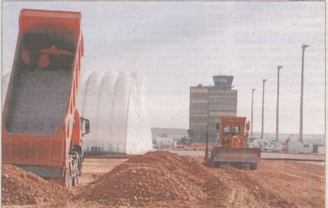
Treballs aquesta setmana a Alguaire per ampliar la plataforma d'estacionament d'avions.
