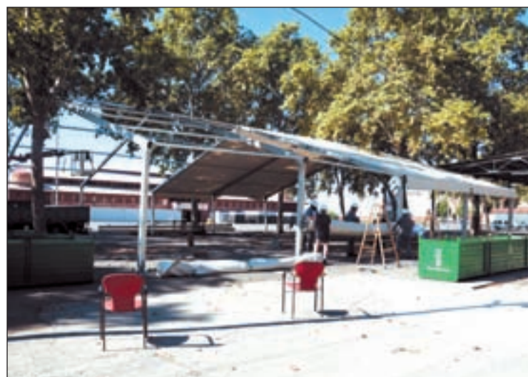
FOTO: ACN / Treballs de desmuntatge de la carpa instal·lada a la Fira
