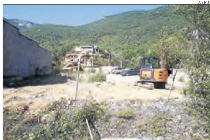
Les obres d'ampliació del cementiri del Pont de Suert.
