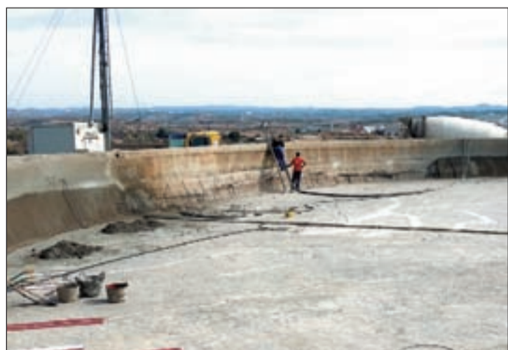
FOTO: Aj. Borges / Imatge dels treballs de reparació del dipòsit
