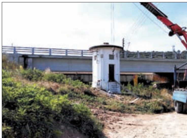
FOTO: Aj. Sant Ramon / Una grua descarrega la nova bomba
