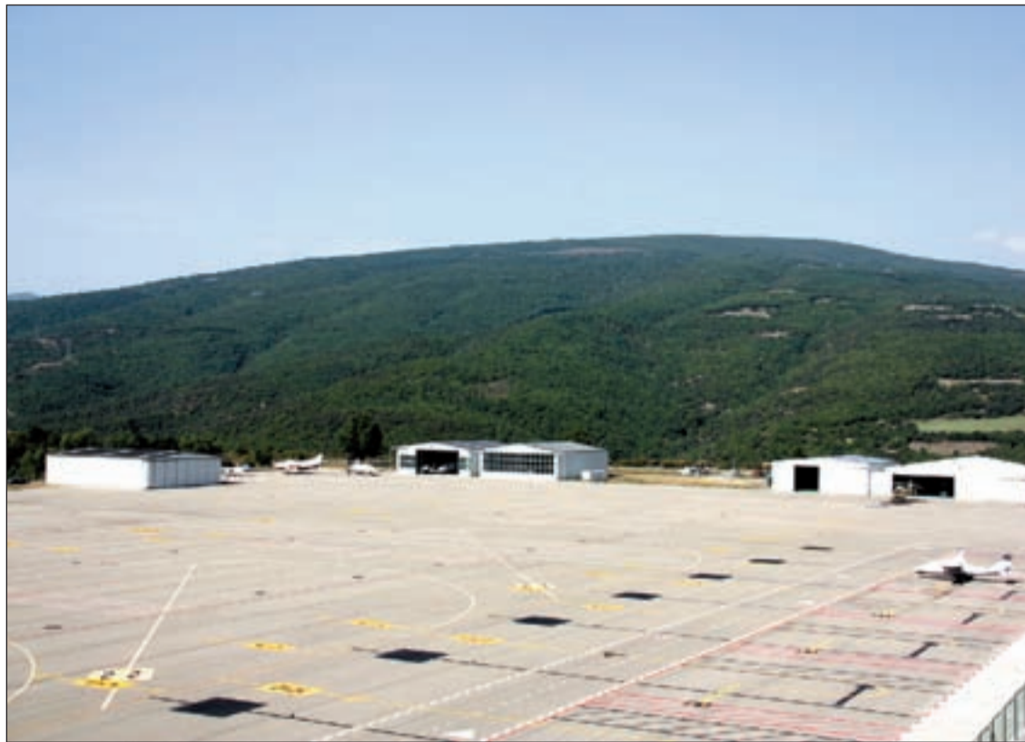
FOTO: A. Lijarcio (ACN) / Pla general de la zona d'aparcament dels avions i dels hangars de l'aeroport
