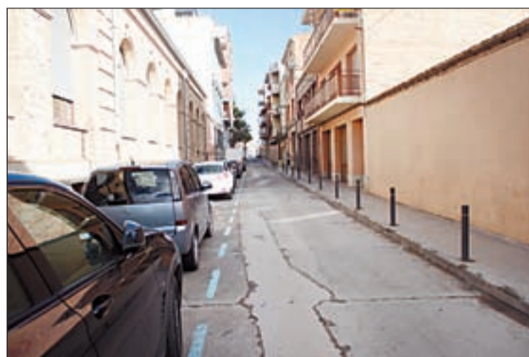
FOTO: Aj. Tàrraga / El carrer es repararà tant a la superfície com al subsòl
