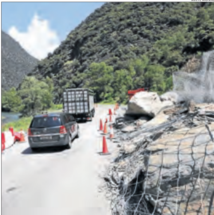
Vehicles al passar pel tram en obres de la C-13.
