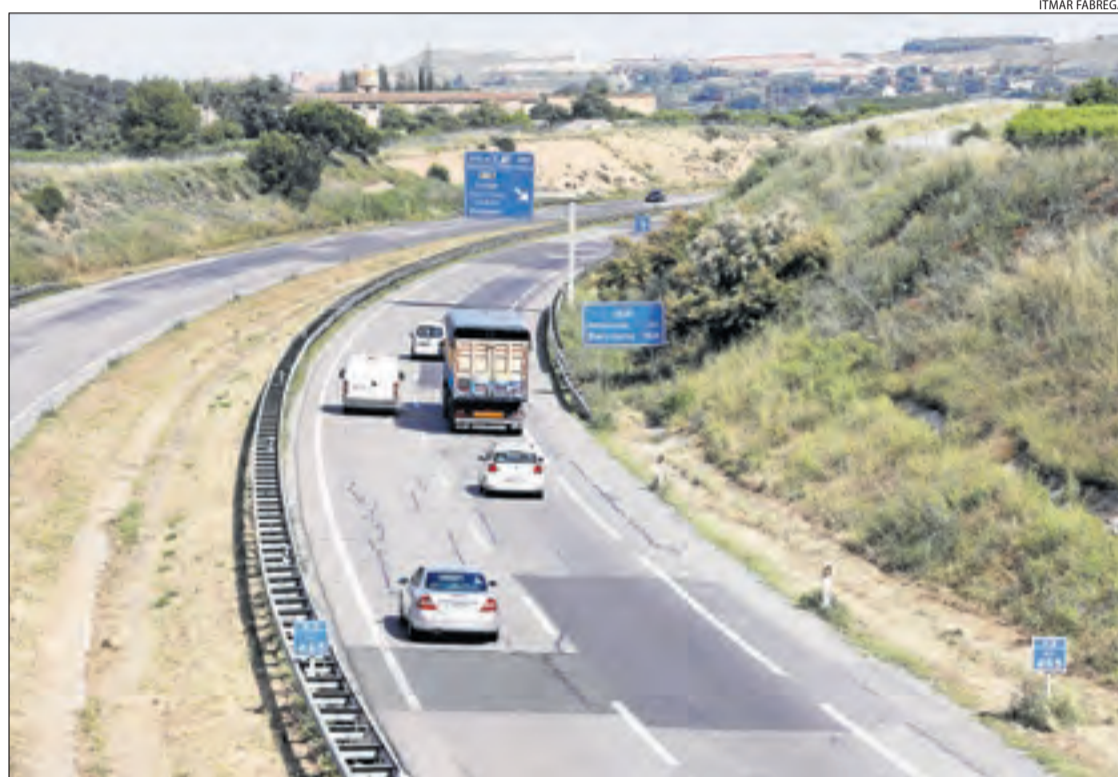
Imatge del tram de l'autovia A-2 on començarà la reforma del ferm l'1 de juny.
