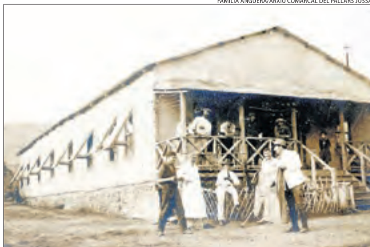
Vista exterior de l'hospital de les obres de la presa de Sant Antoni.
