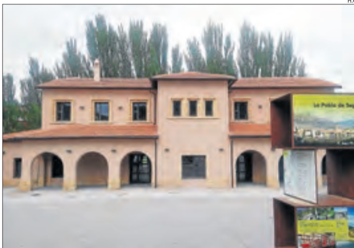
Imatge de l'exterior de l'estació de tren, amb el centre BTT.
