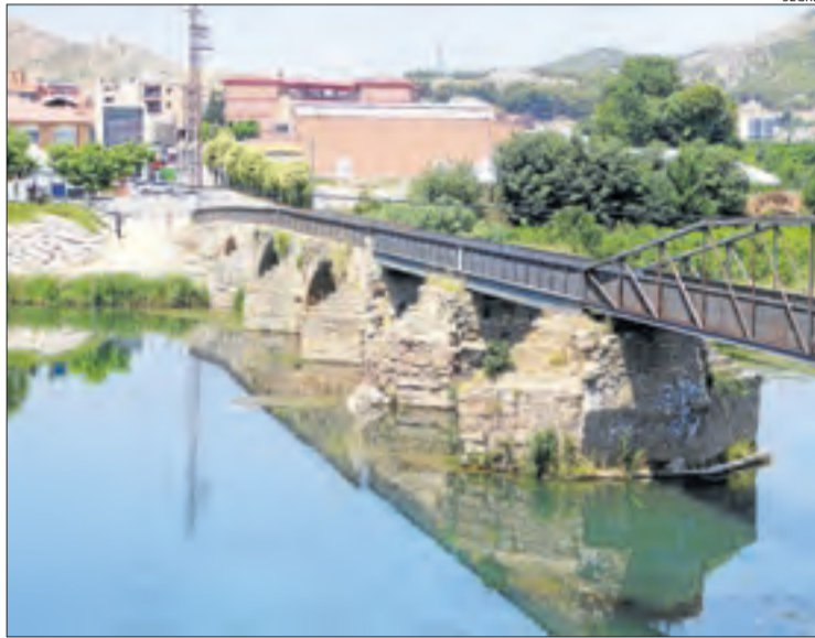
Vista general del pont medieval d'Alfarràs.
