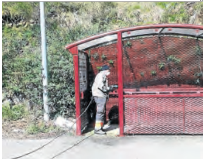
Desinfecció d'una parada de busos a Aran.
