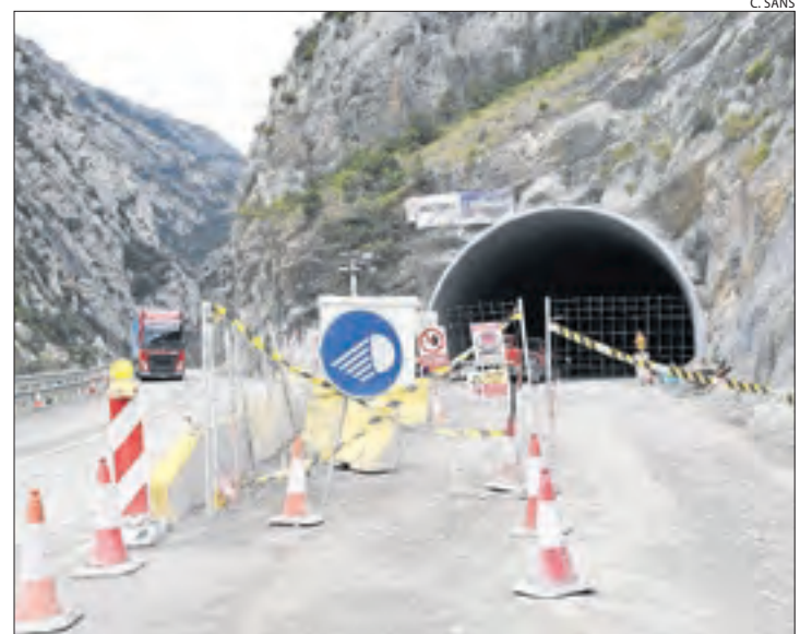
Les obres del túnel de Trespunts, que ahir ja estaven paralitzades.
