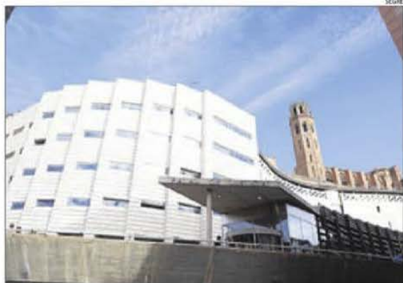
Imatge de l'edifici judicial del Canyeret.
