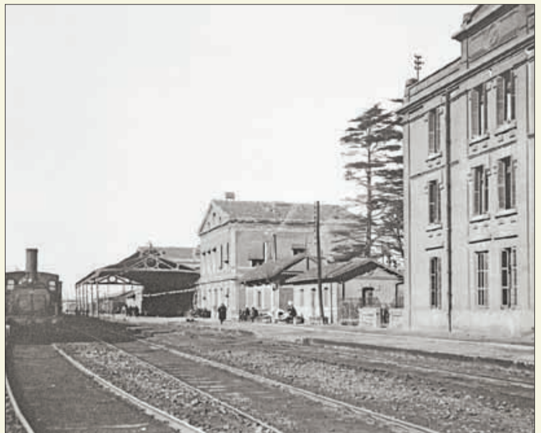
FOTO: Josep Porta (IEI) / Estació antiga de Lleida (any 1926) i, a l'esquerra, la nova en construcció
