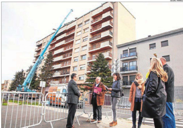
Aquest carrer es manté tancat pels danys registrats a l'edifici del fons.
