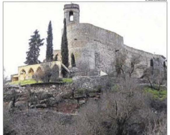
Imatge del mur que va caure al cementiri de Montfalcó Murallat.
